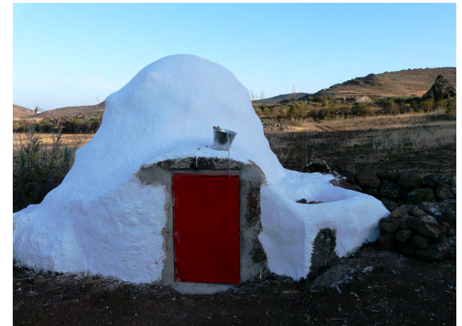
Aljibe recuperado, restauración de patrimonio cultural en beneficio de la biodiversidad y el paisaje. Gran Canaria. ACEC
