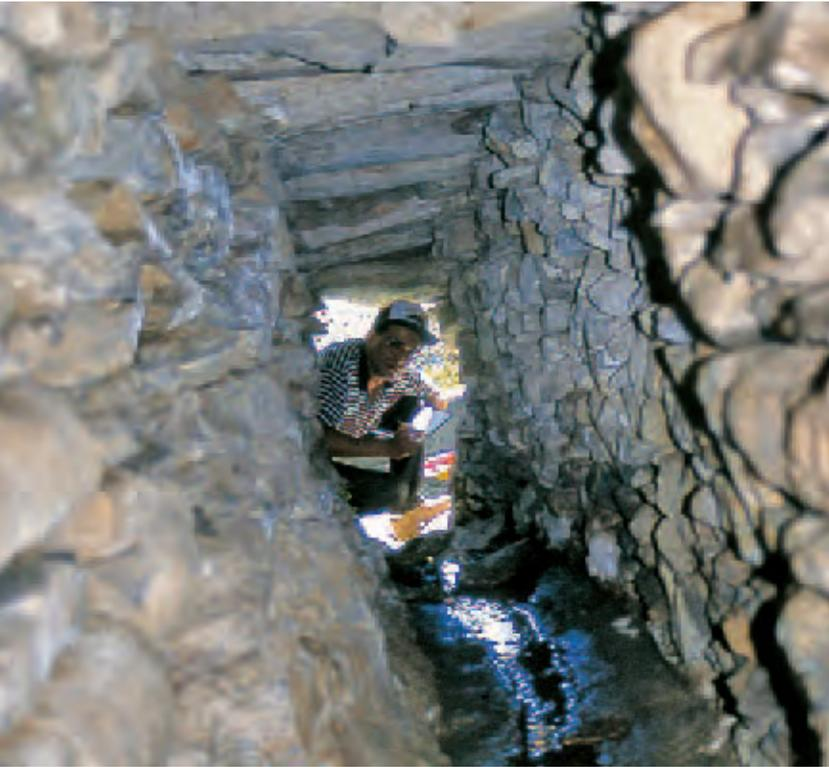
*1.2 Interior y exterior de una pequeña "mina" (es un pequeño qanat) para la extracción de agua localizada en el despoblado medieval de Alhabia, en el término municipal de Alcudía de Monteagud (Sierra de Filabres). Al final de la galería (de 7,2 m. de longitud y 1,1 m. de altura) hay una cámara vertical, una especie de pozo, de unos 2,5 m. de altura y 1,5 x 1,4 m de sección transversal.*
