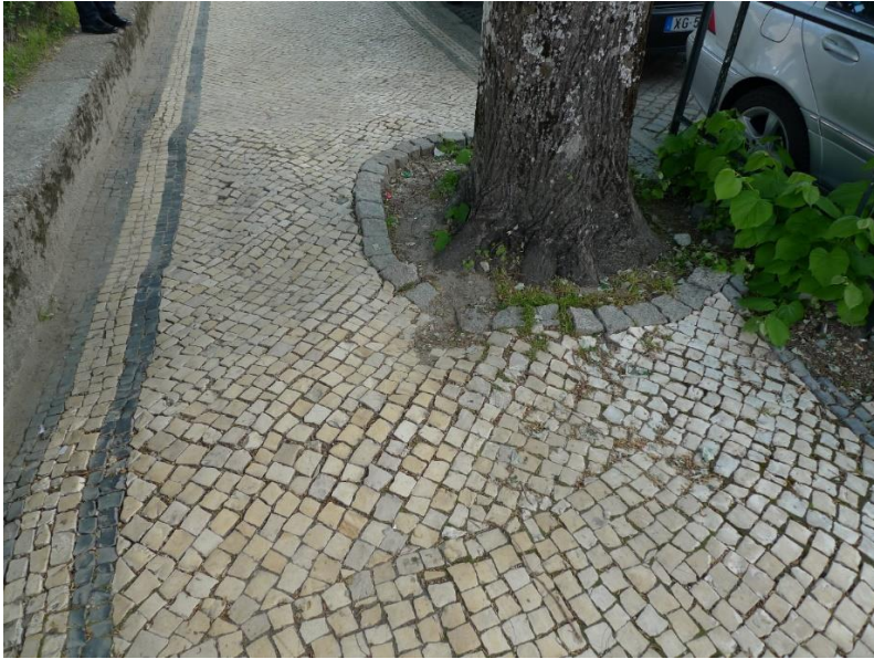
Tilo en alcorque con pavimento adoquinado en Guarda, Portugal.
