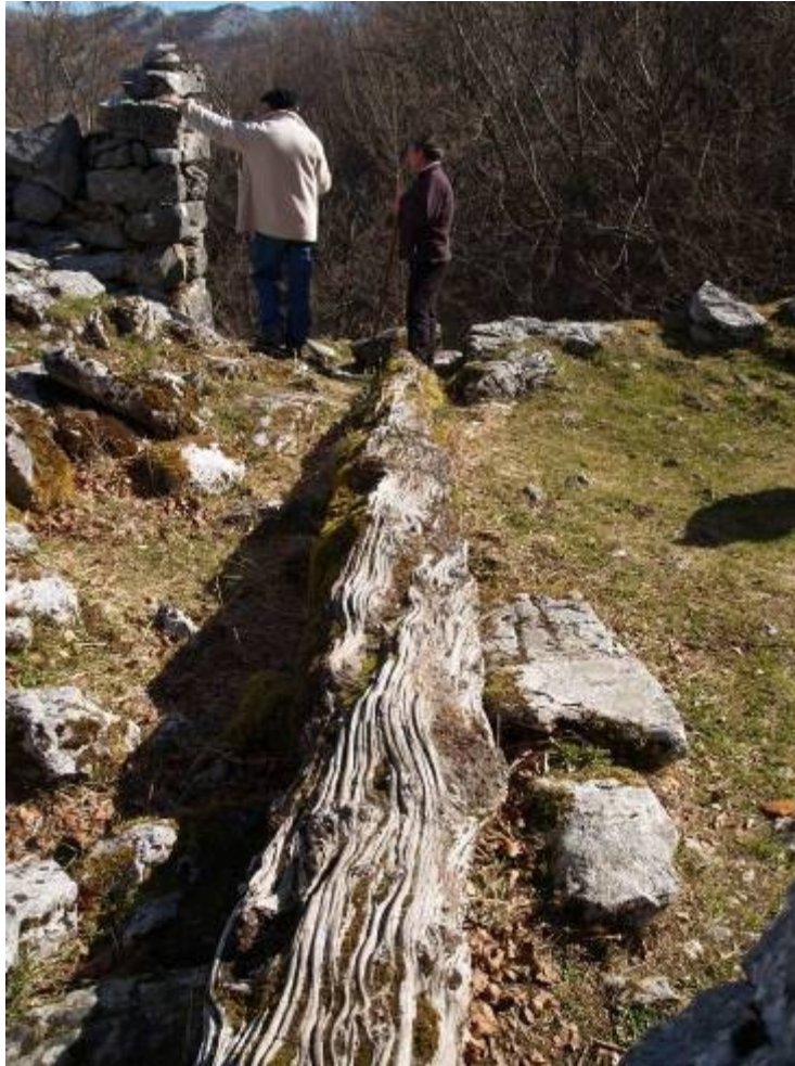
La viga de tejo, tradicional por su duración y resistencia, para construir el cumbral de muchas bordas o cabañas de pastores es la única parte que ha sobrevivido en ésta de Itxina (Vizcaya)
